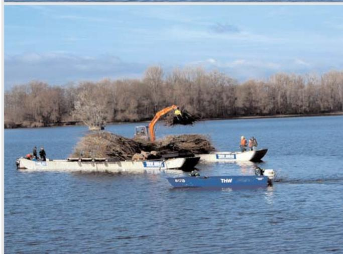
Von einem Zwischenlager aus wurden die Totholzbündel durch das THW auf eine schwimmende Arbeitsbühne verladen und dann über dem Zielbereich abgeworfen.
