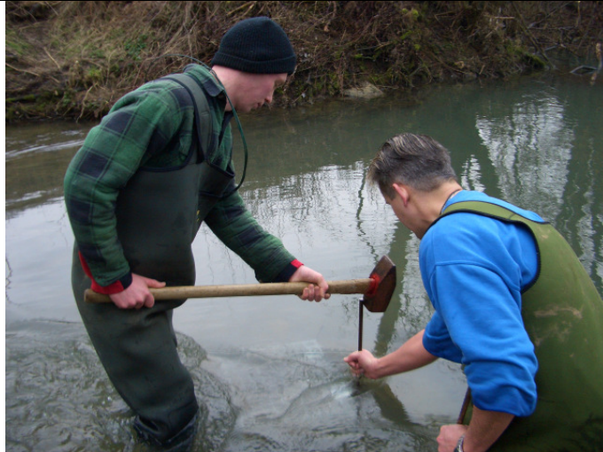
Zum Schutz gegen Verdriften der Körbe bei Hochwasser werden 2 Eisenstangen in der Sohle verankert die mit dem Körben verbunden werden.
