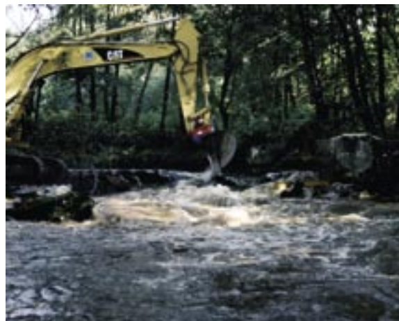
Wiederherstellung der Durchgängigkeit an der Mitternacher Ohe
