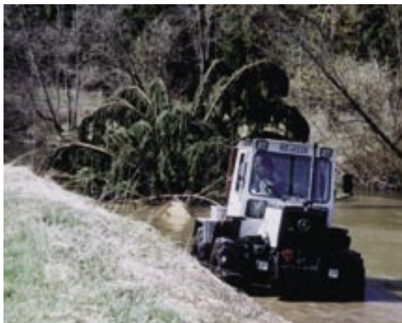
Totholzeinbau an der Wertach
